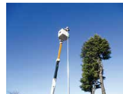
道路照明灯工事
