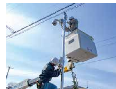
防犯設備工事
