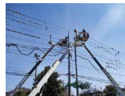
配線設備工事
